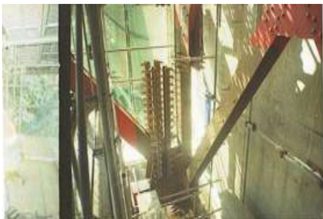
写真-8 ジャッキ支点部補強
