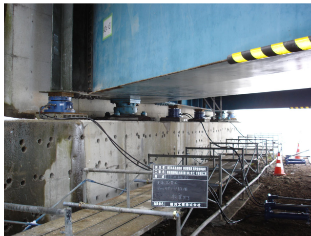
写真-1 鋼箱桁のジャッキアップ状況
