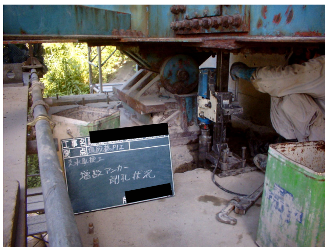
写真-10 増設アンカー施工
