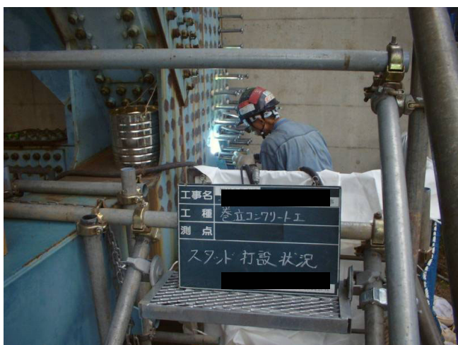
写真-7 スタッド溶接
