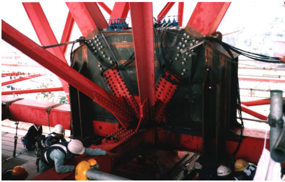
写真-2 ガセット補強
