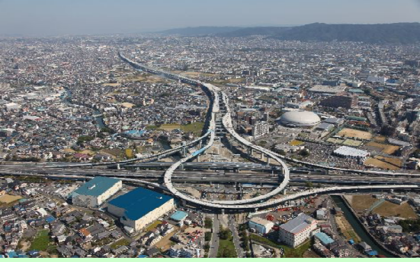
施工完了状況(平成21年10月15日)
