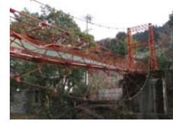
右岸下流側より撮影
