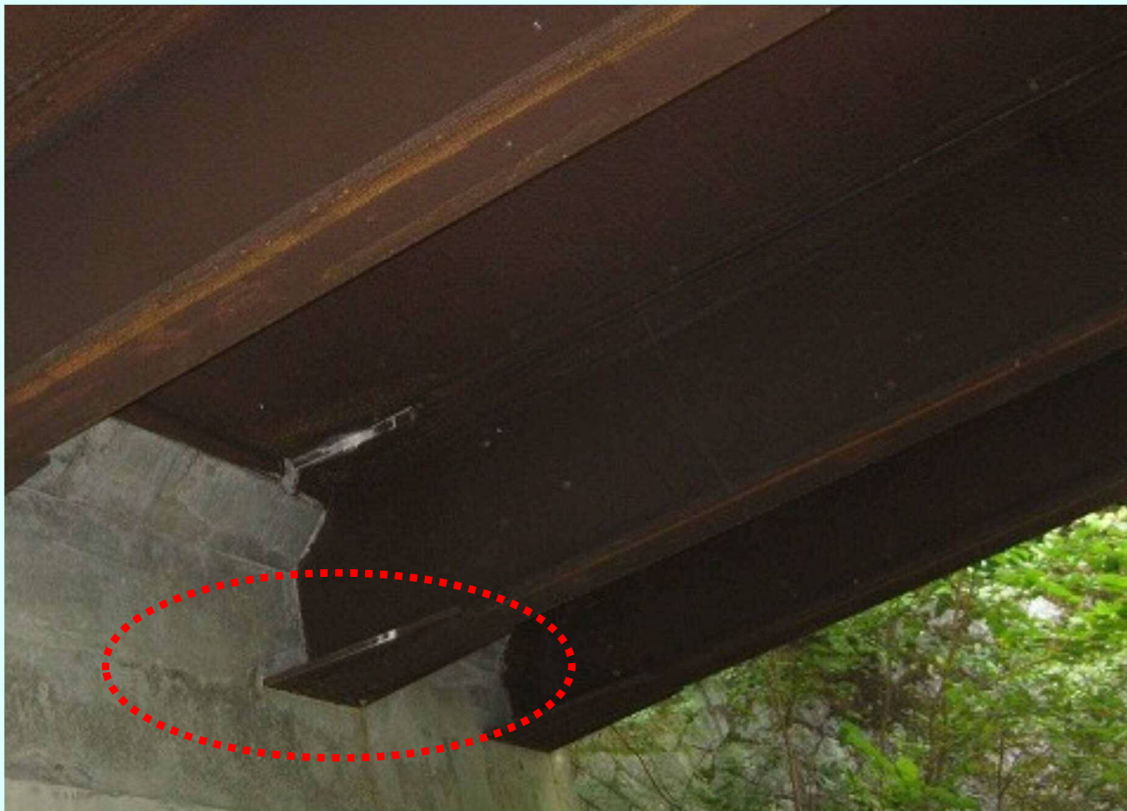
埋込部フランジを拡幅した事例
