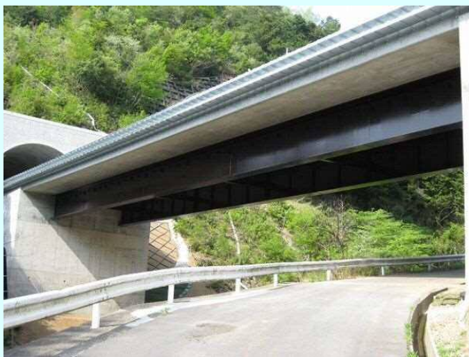
ハタボキ谷橋(2008年竣工)
