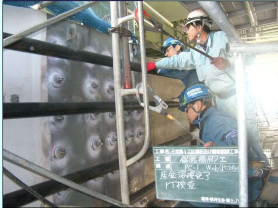
丸座金溶接後 PT検査状況
