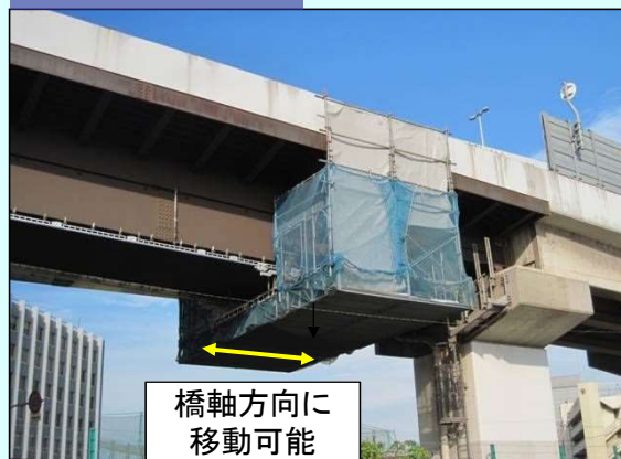
移動式ラック足場設置
