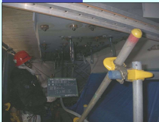
樹脂モルタル注入
