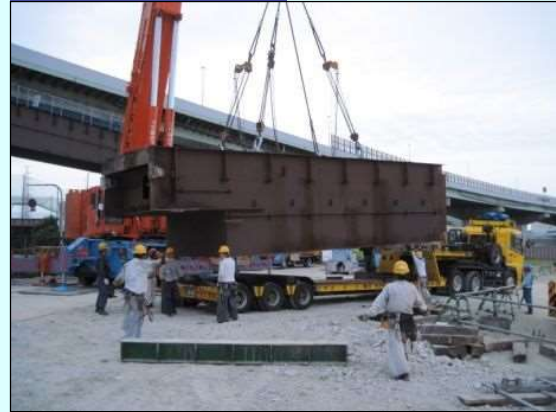
再利用主桁 工場へ輸送
