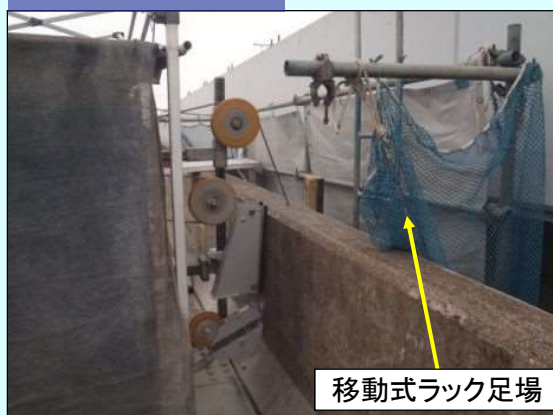
壁高欄鉛直切断 (乾式ワイヤーソー)
