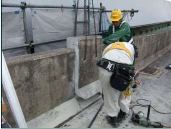
ジョイント部 ブロック撤去
