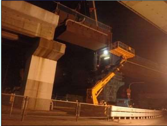
主桁撤去 (夜間作業)
