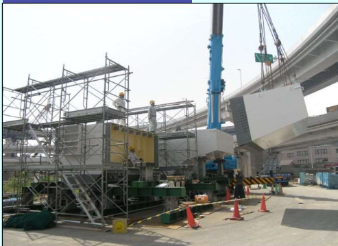
横梁地組立て
