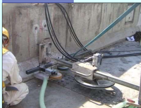
壁高欄水平切断 (乾式ワイヤーソー)
