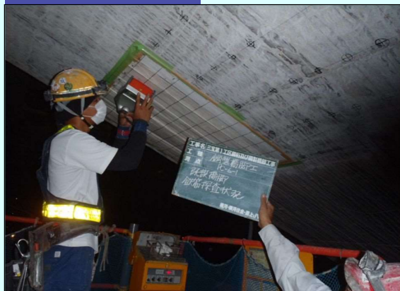
鉄筋探査
