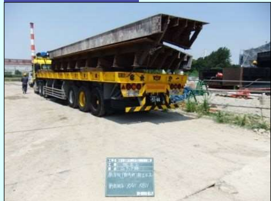
再利用側床版 工場へ輸送
