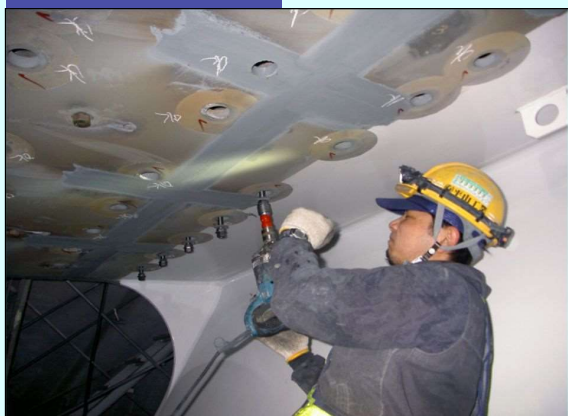
ケミカルアンカー設置
