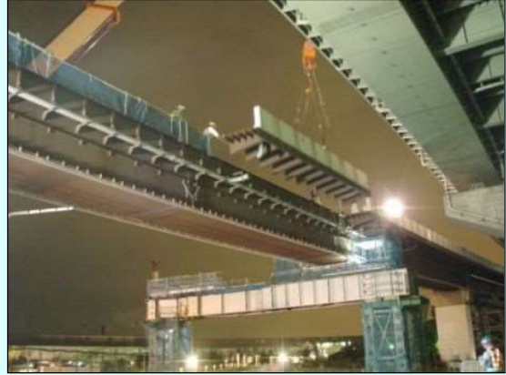
側床版撤去 (夜間作業)
