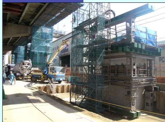
複合コンクリート打設
