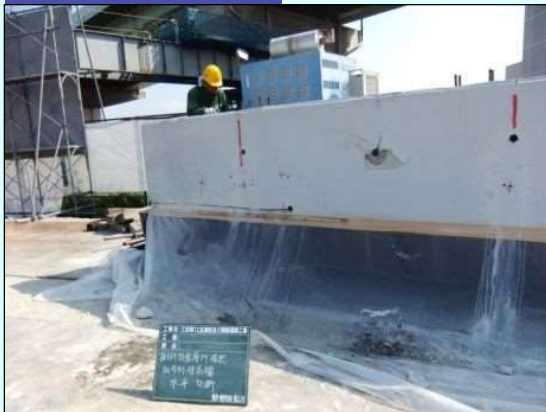
壁高欄撤去 (レベルソー)
