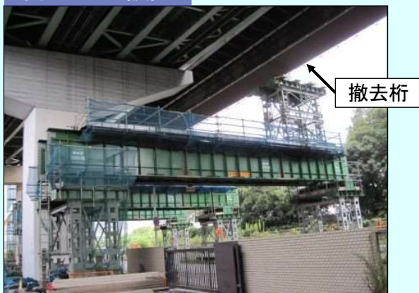
門型ベント設置
