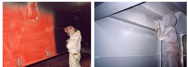
a) 施工状況（左側：外面、右側：内面）
