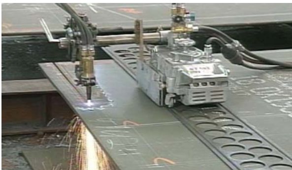
写真-5 ポータブルガス切断
