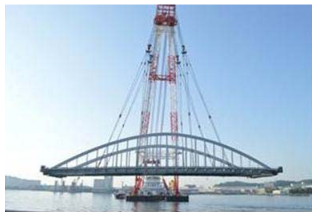
写真-34 隅田川橋りょう
