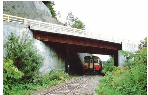
写真-33 尻別跨線橋
