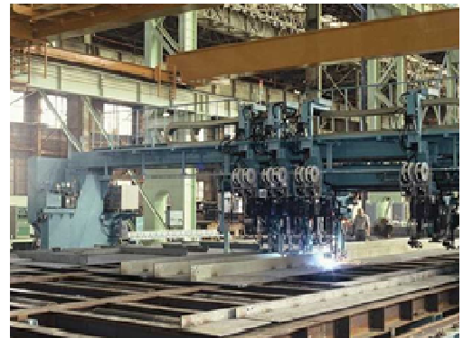
写真-14 縦リブ組立装置
