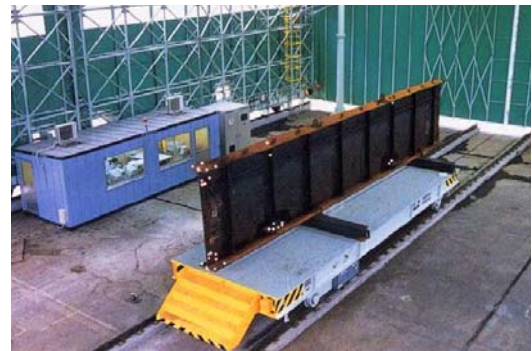
写真-25 トータルステーションによる自動計測
