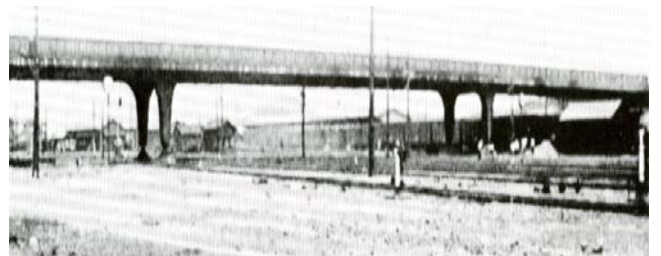
写真-18 田端大橋
