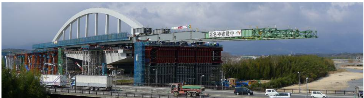
写真－9 送り出し架設全景（P2側）
