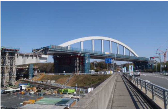
写真-11 送り出し完了
