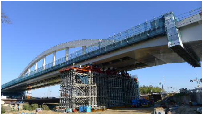
写真-14 降下完了
