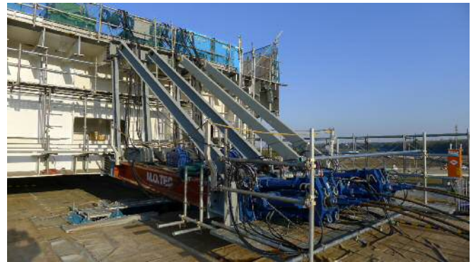
写真-4 ダブルツインジャッキ設置
