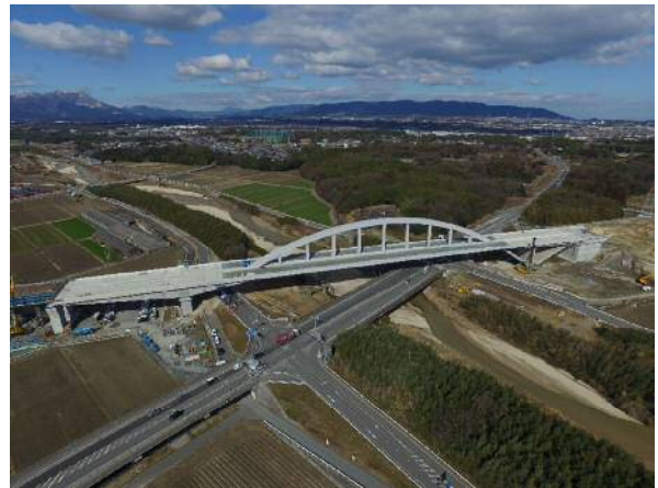
写真-1 施工完了
