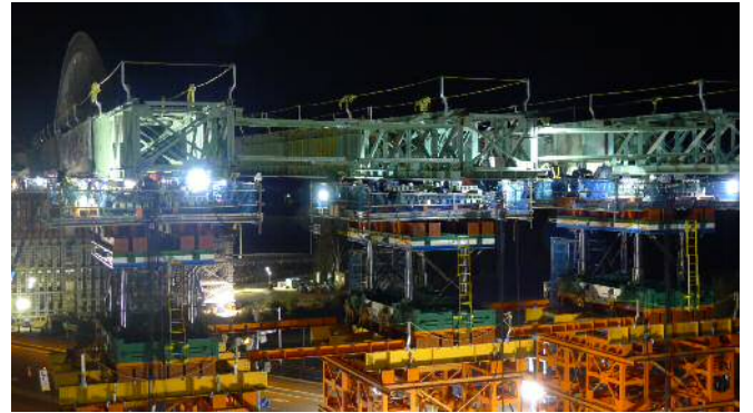
写真－7 一夜ベントリフトアップによるたわみ取り
