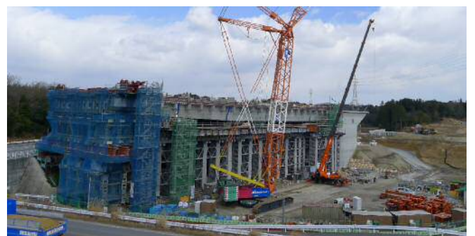
写真－8 送り出し架設全景（P1側到達部）
