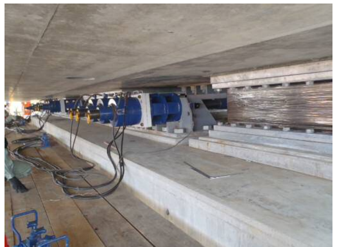
写真-15 セットバック作業状況
