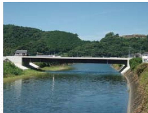
大牟田高架橋
