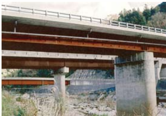
【JH高知自動車道 銅山川橋上下線および高知県道】
