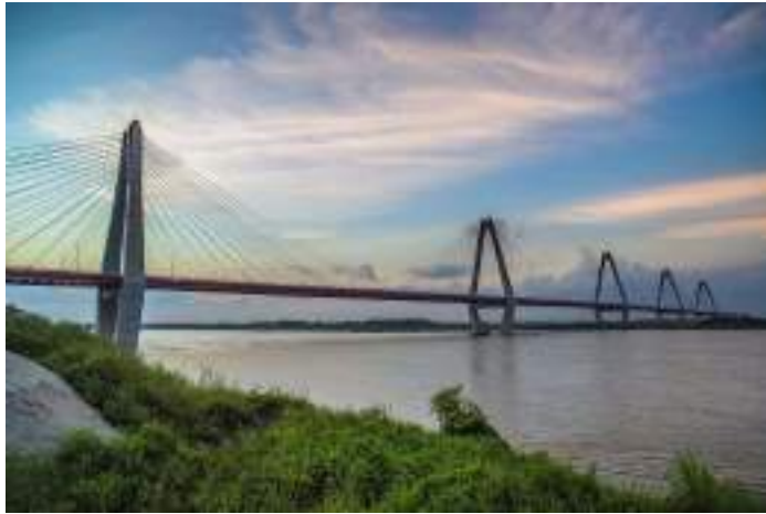
世界的にも珍しい6径間連続合成斜張橋
