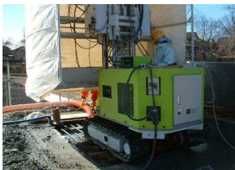
■ ロボットによるはつり (ウォータージェット)
