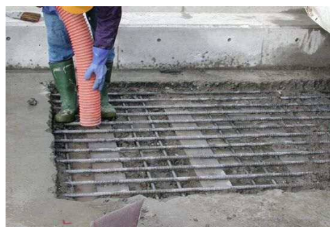
■ コンクリートはつり後の状況
