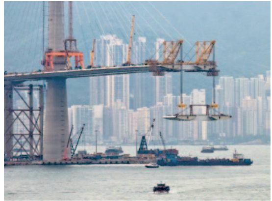
写真-9 主桁セグメントの架設
