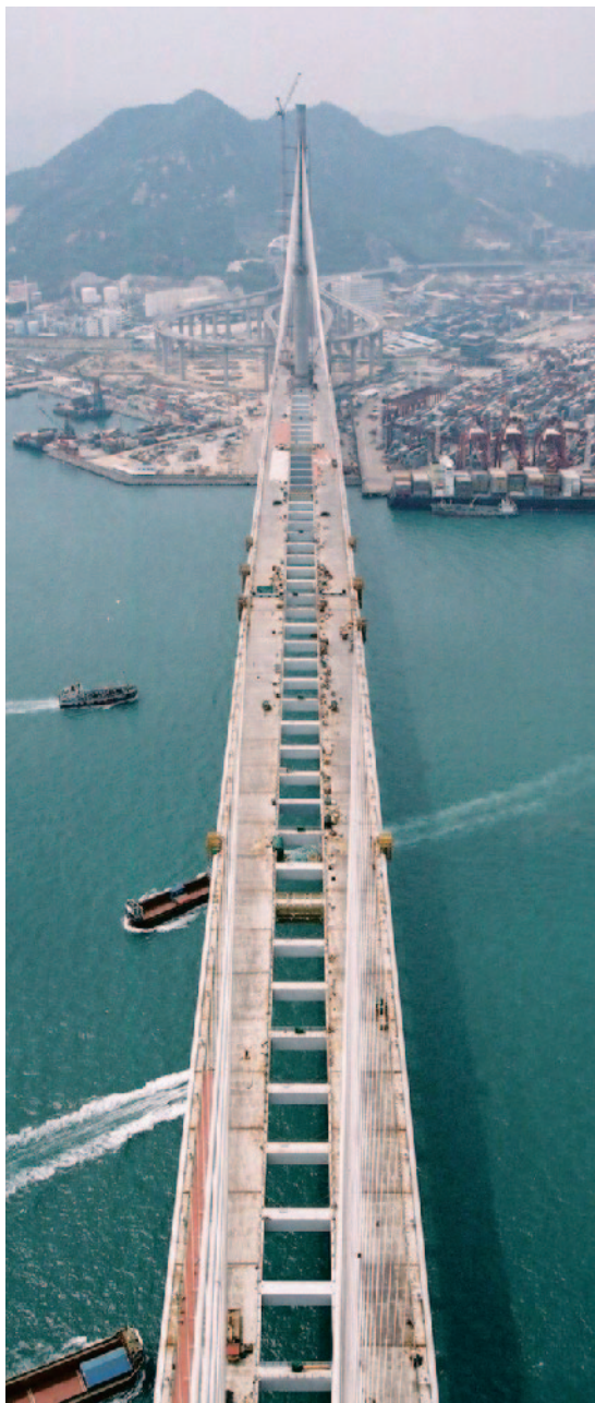
写真-12 塔頂からの全景(閉合後)
