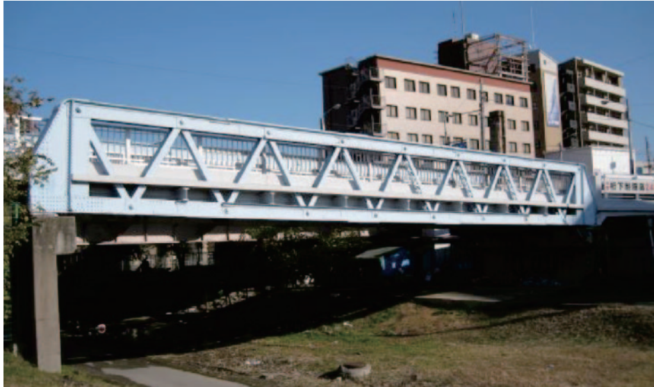
写真-4 浜中津橋
