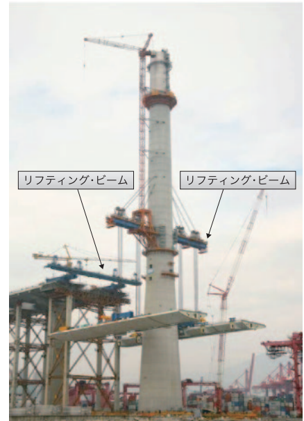
写真-7 一括吊上げ状況
