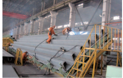
写真-3 パネル溶接回転治具
