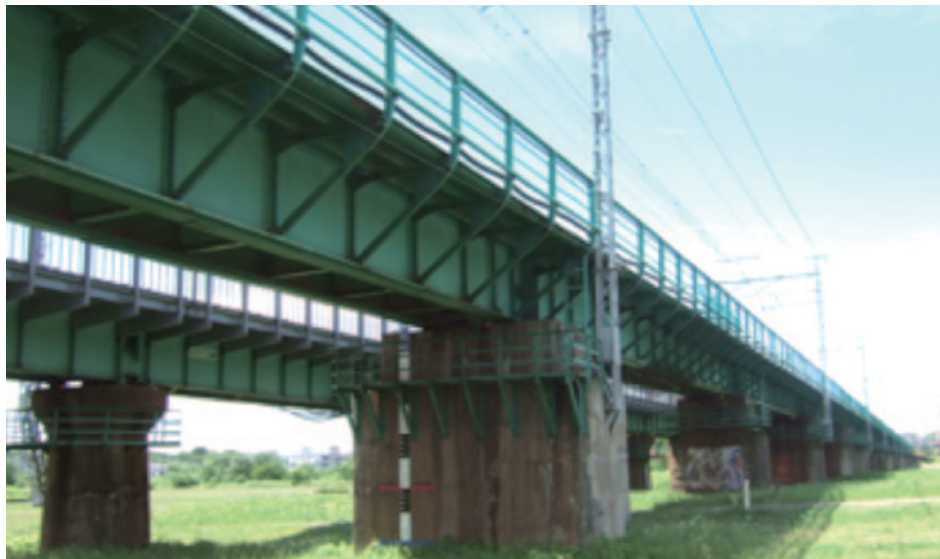
写真-6 多摩川橋梁
