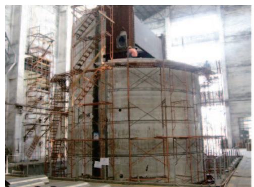
写真-4 ステンレススキンおよびアンカーボックス仮組立
