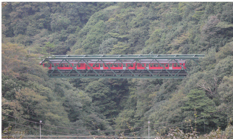
写真-5 早川橋梁
