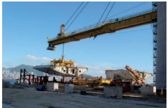
写真-6 ブロックの水切り状況
