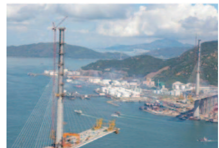
写真-8 張出し架設中の全景
