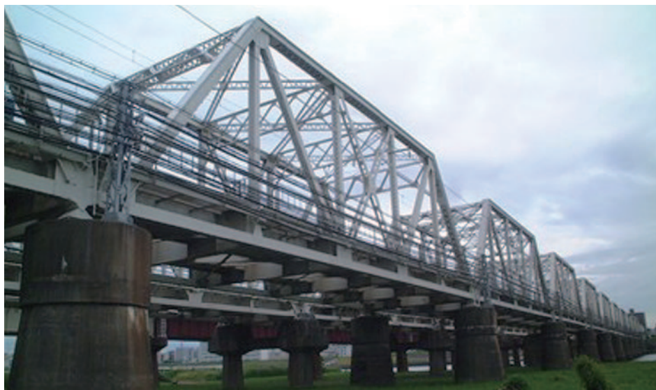
写真-9 上淀川橋梁(上り線)
