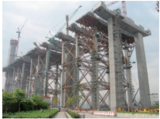
写真-5 コンクリート桁の支保工
