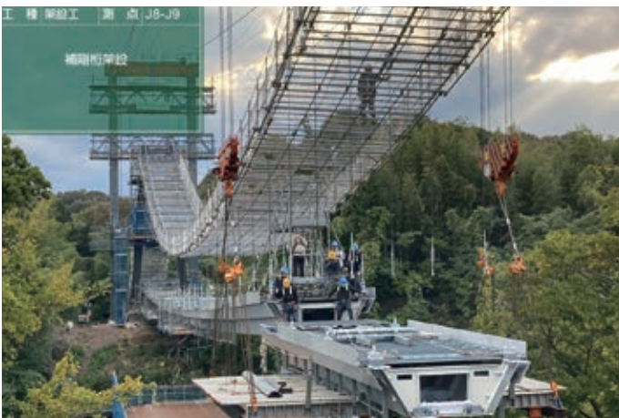
補剛桁架設 (昼間)
