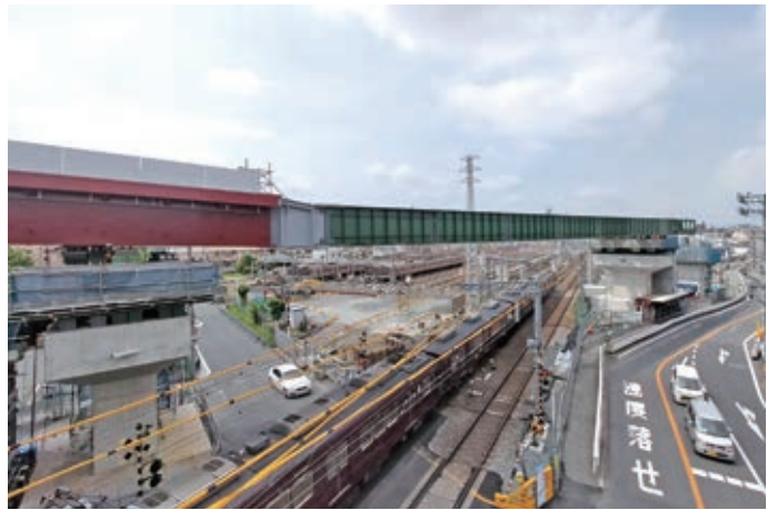
(南正雀跨線橋) 送出し架設状況
