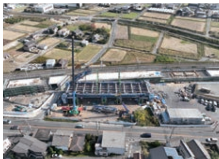
現場での地組立中
