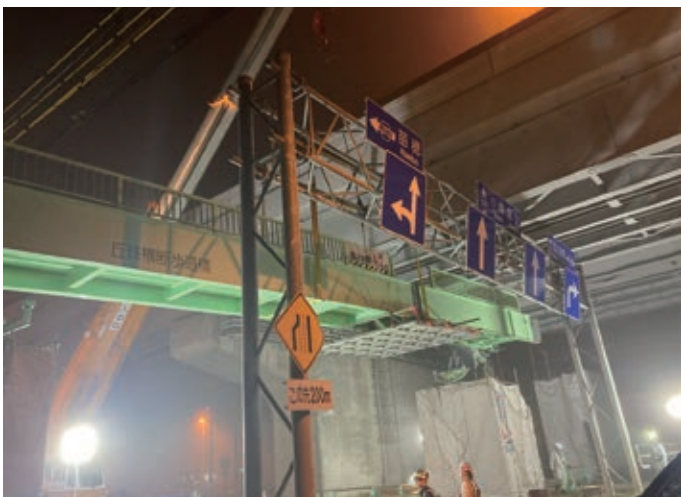
主桁架設 丘珠横断歩道橋
