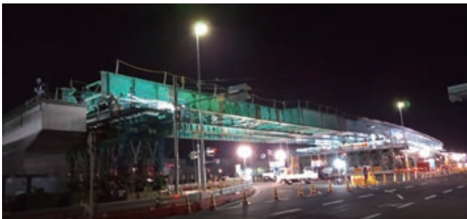
送出し架設状況
