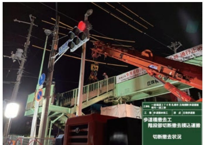
階段部撤去 丘珠横断歩道橋
