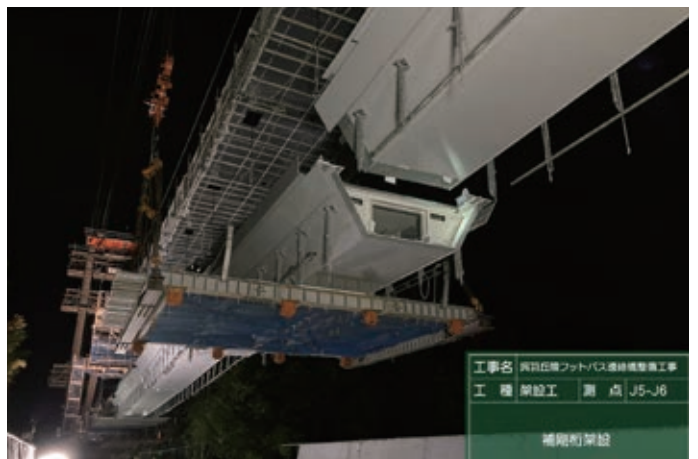
補剛桁架設 (夜間)
