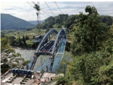
補剛桁架設中
