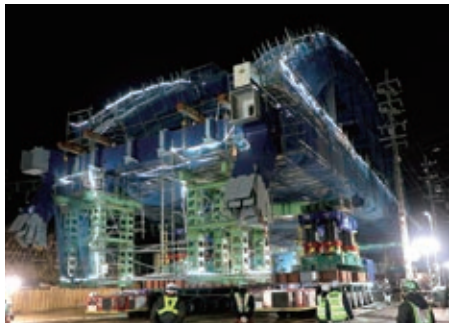
多軸台車搭載一括架設前
