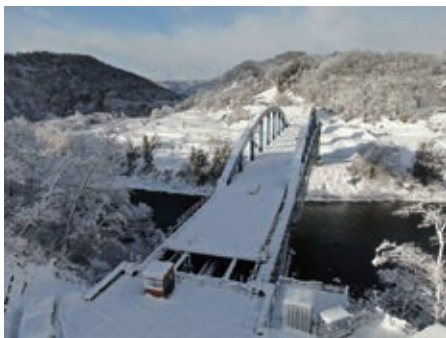
架設完了(冬季期間中)
