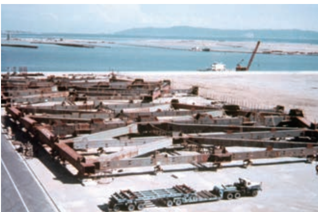
港大橋 部材の仮組の様子
