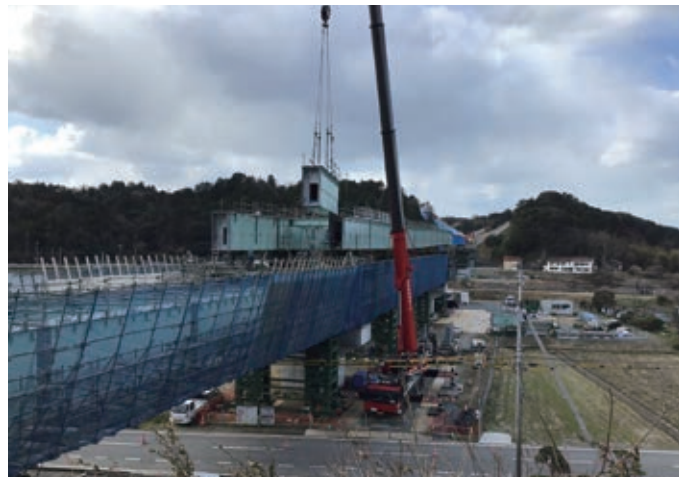
送し桁地組立
