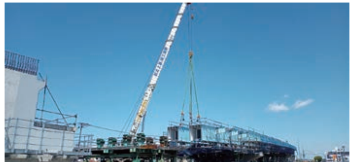
クレーンベント架設状況
