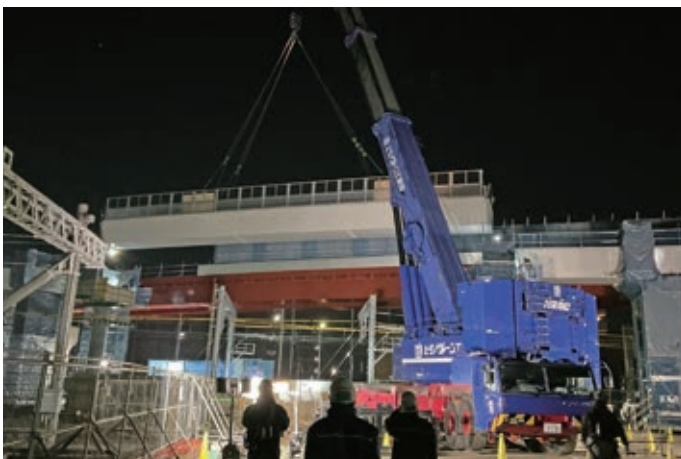
(岸部南横断歩道橋) 落とし込み架設状況
