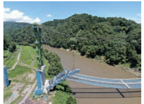
アーチリブ架設中
