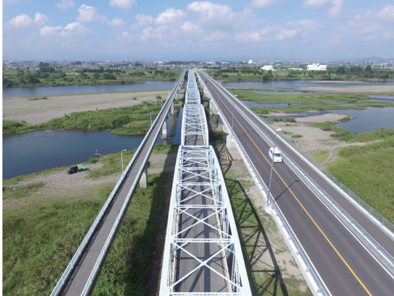
(左：旧上武大橋 中央：旧上武大橋本橋 右：新しい上武大橋) 全線供用開始時 平成30年8月
