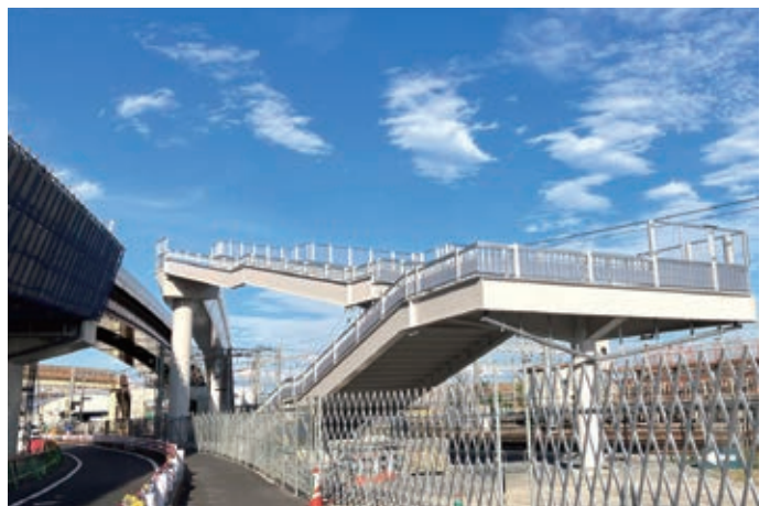
(岸部南横断歩道橋) 完成写真
