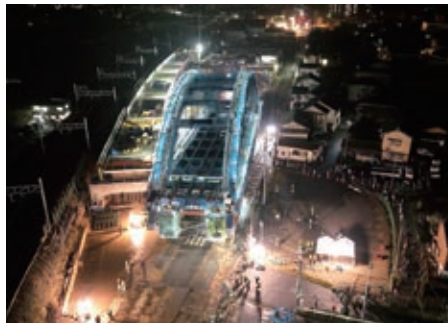
多軸台車で定位置へ移動中
