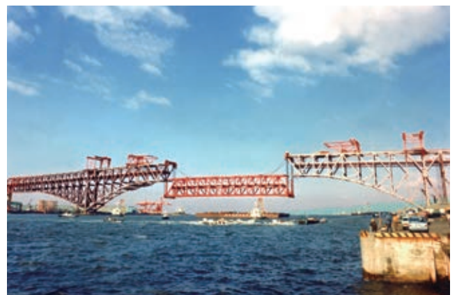
港大橋 一括吊上げ架設の様子
