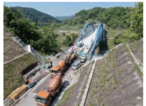
コンクリート打設中
