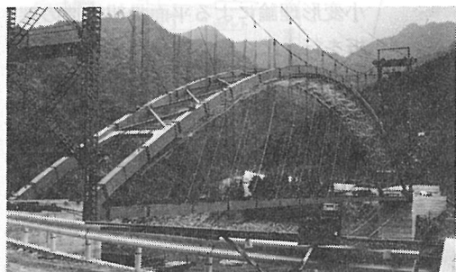
写真-3 斜吊材の設置終了
