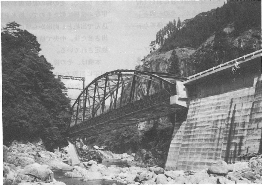
写真-5 観音岩橋
