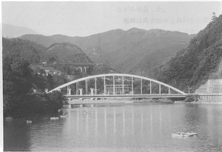
写真-10 相模湖大橋
