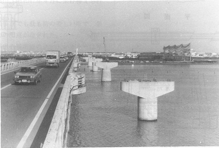
写真-12 湘南大橋
