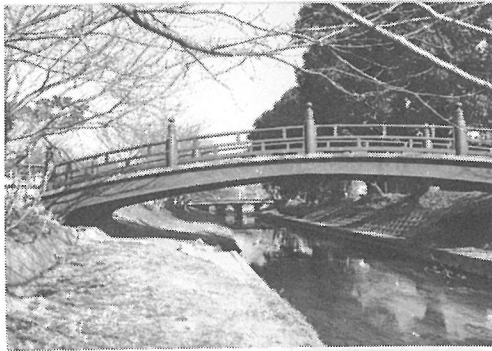
◆写真-5(1) 新しい鋼製の神橋
