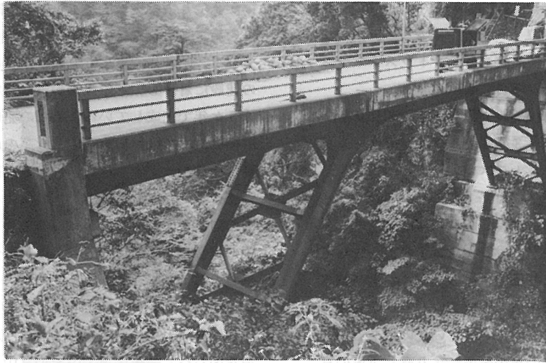
写真-10 松ヶ谷橋
