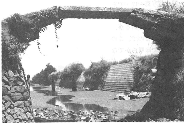
写真-10 防府の柵築らんかん橋（1980.8）
