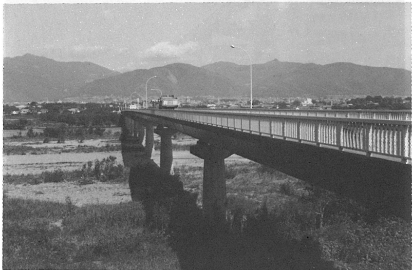
写真-9 瀬 詰 大 橋
