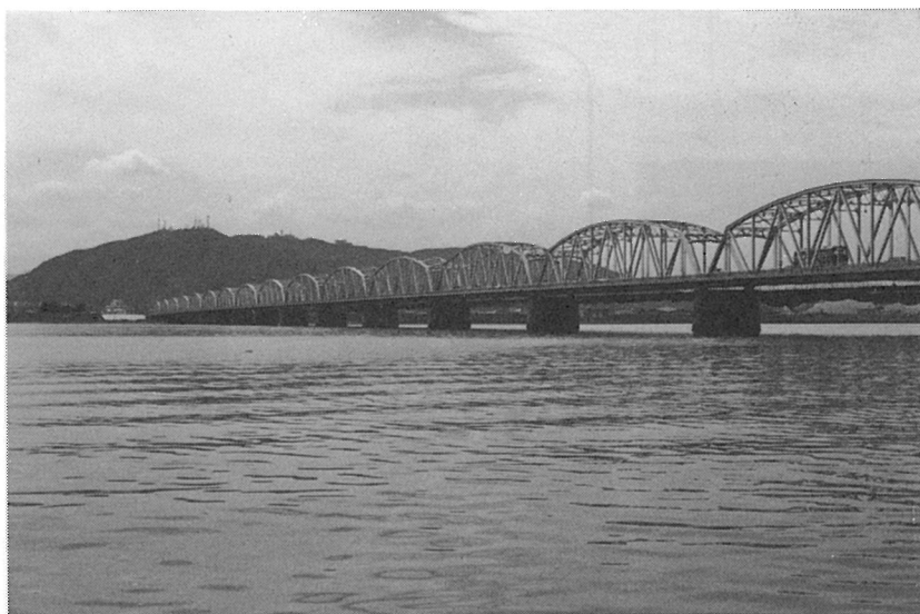
写真-13 吉野川橋
