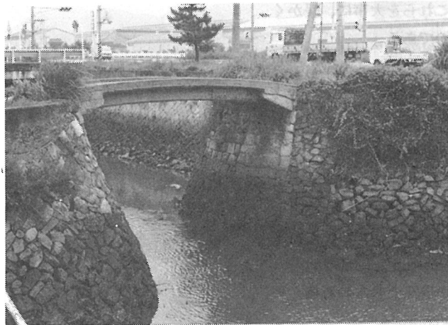
写真-11 らんかん橋に似せて作った コンクリート橋（1980.8）
