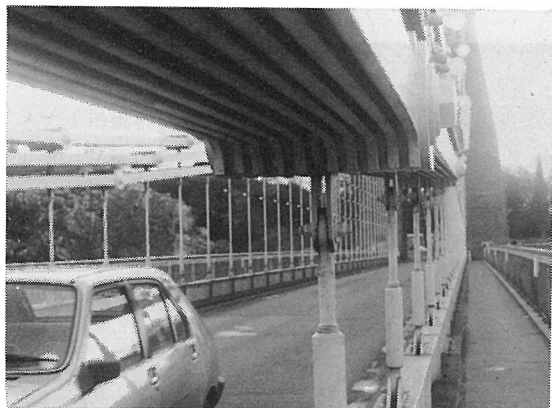
クリフトン橋のチェーン（その2）
