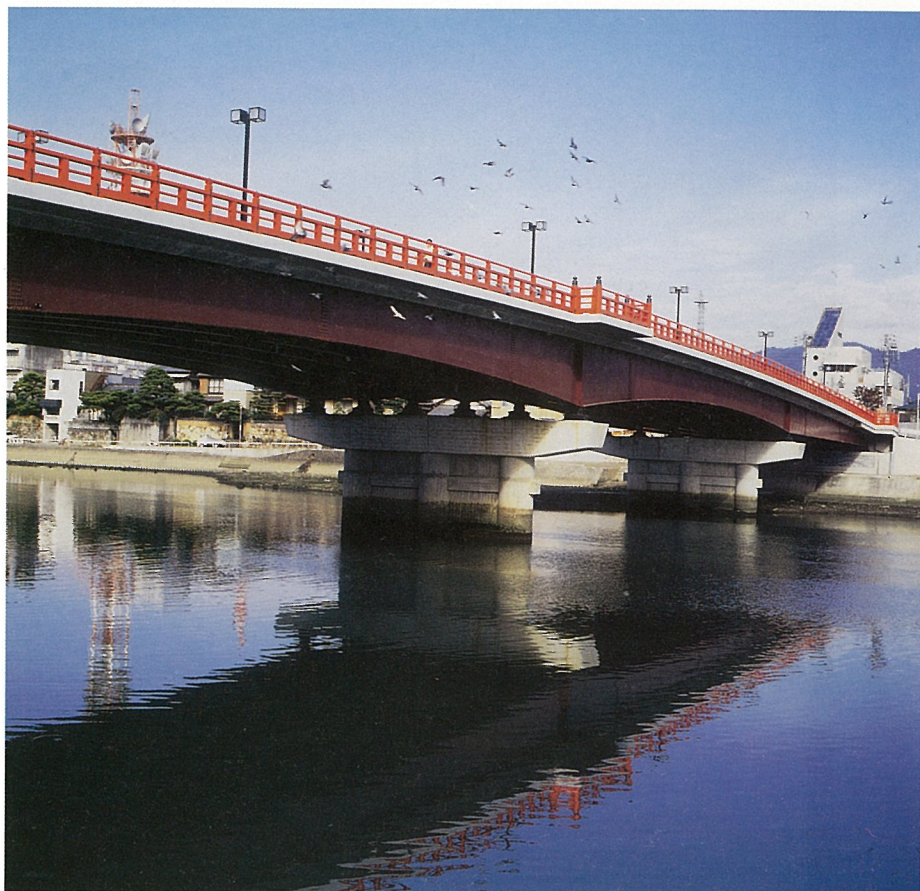
天神橋 発注者 高知市役所 型式 4径間連続非合成 成钣桁 橋長 140m 幅員 14.5m 鋼重 397 t 所在地 高知県高知市
