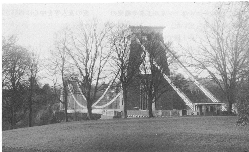
クリフトン橋遠景
