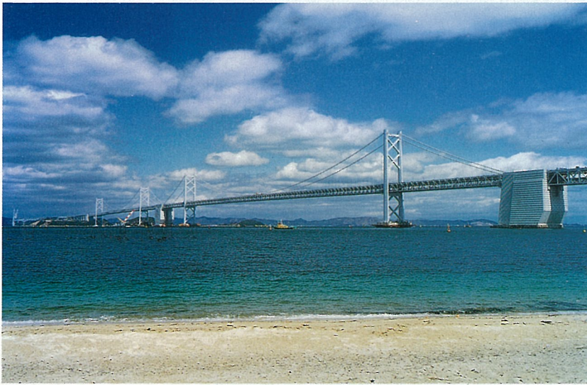
南・北備讃瀬戸大橋
