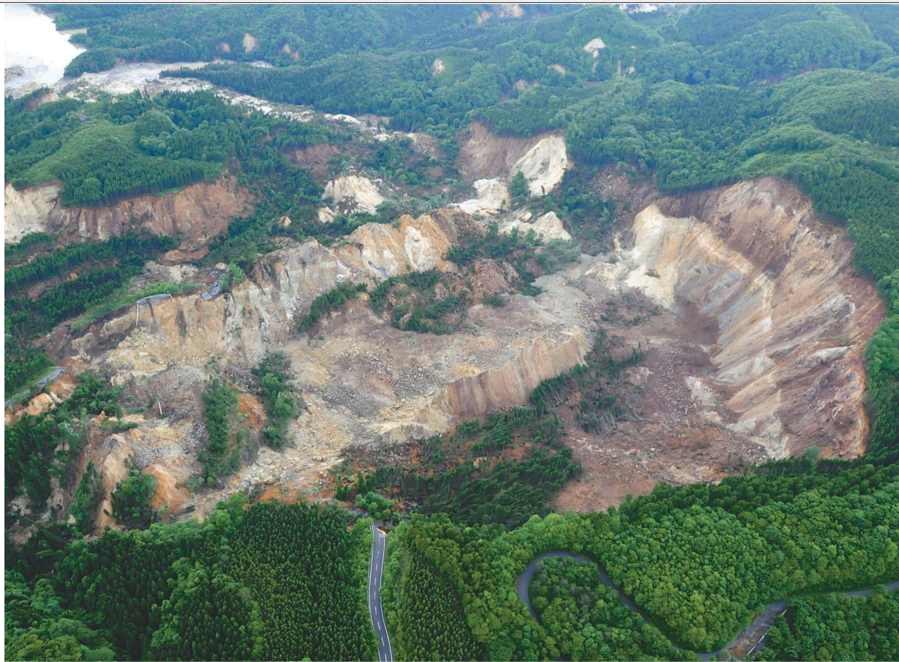
岩手・宮城内陸地震で山全体が崩落した宮城県栗原市の現場
