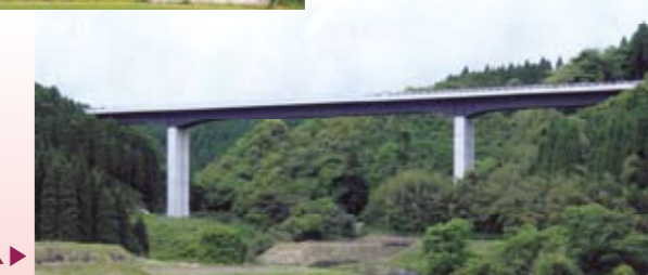
今別府川橋 / 3径間連続複合ラーメン橋▲▶
