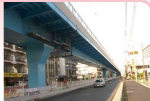
▼新小岩陸橋 / 4径間連続鋼床版箱桁ラーメン橋2連▲
