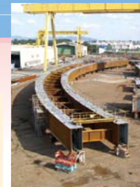
▲仮組立中の曲線桁
