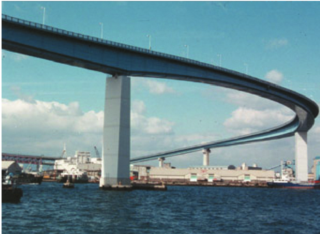
桁橋として日本最大の250mのスパンを持つ大阪のなみはや大橋
