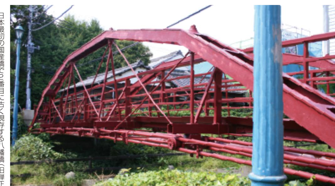
日本最初の国産橋で2番目に古く現存する八幡橋(旧弾正橋)。1878(明治11)年に東京の楓川に架けられた橋長15.1mのボーストリングトラス形式の弾正橋は、関東大震災後の復興計画により1992(昭和47)年に撤去となり、江東区深川の富岡八幡宮の境内の裏側に移設され、名を八幡橋と改めて人道橋として再生されました。1950(昭和25)年に国指定重要文化財となり、大切に使われています。
