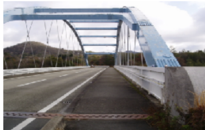
1984(昭和59)年に完成した、橋長99mのニールセン・ローゼ橋。アーチ部材と補剛桁の間にケーブルを網目状に張ることで、全体の重量を軽くすることができ、たわみ振動の面で有利になる構造を持っています。
