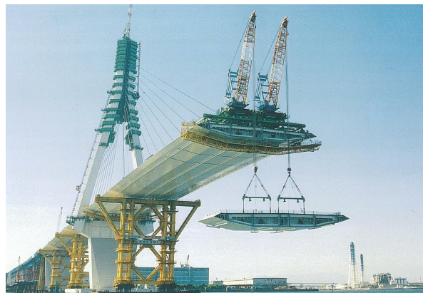
斜張橋主桁の架設
