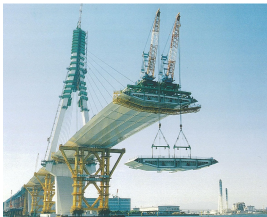
斜張橋主桁の架設
