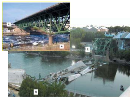
ミシシッピ川橋梁（1967年竣工）の 落橋（2007年）
