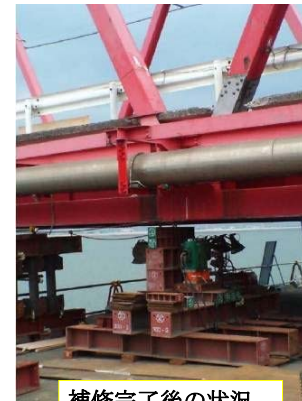
補修完了後の状況
