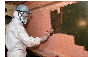
塗膜除去状況
