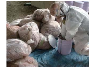
塗膜回収状況
