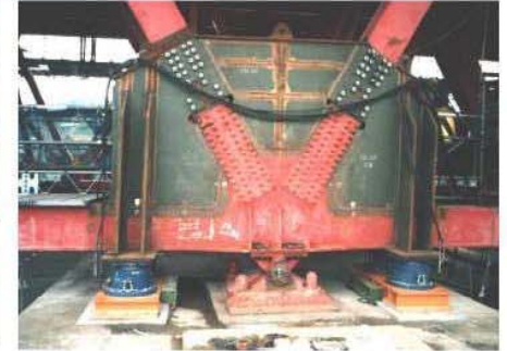
ジャッキアップ補強完了
