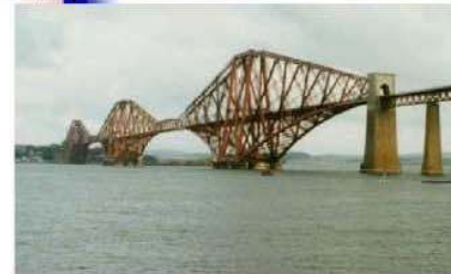
フォース鉄道橋 1890年竣工
