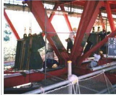
拡幅部材の搬入
