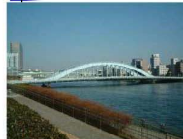
永代橋 1925年竣工
