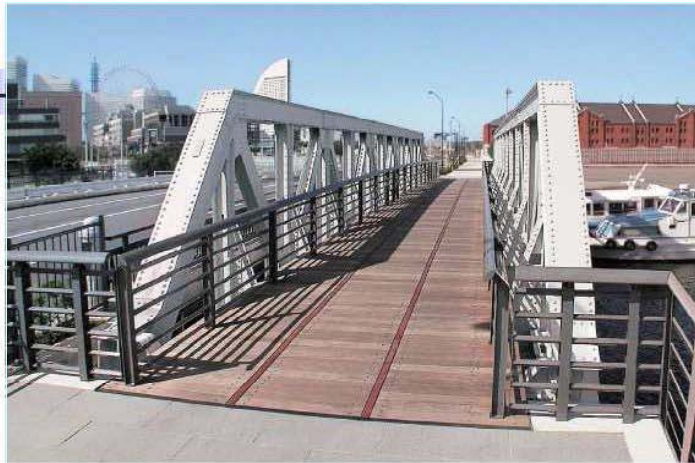
大正2年(1912年)鉄道橋として完成 都市化による道路拡幅整備により歩道橋として活用
